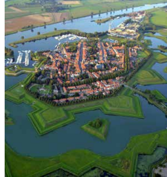
DE VESTING MET RAVELIJNEN EN BASTIONS
